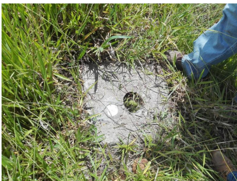
Ilustración 3. Plataforma de perforación con diamantina
