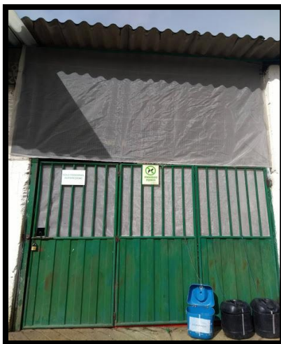
Figura 40. Cambio de mallas en área de clasificación por material de fácil limpieza.
