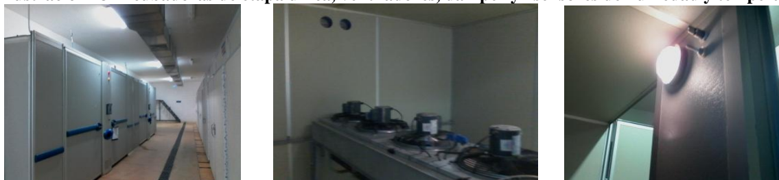
Ilustración 13 Incubadoras de etapa única, ventiladores, dámper y sensores de humedad y temperatura
