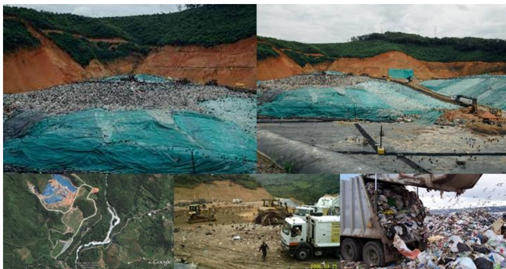
Imagen 6, relleno sanitario (Relleno sanitario, s.f.)
