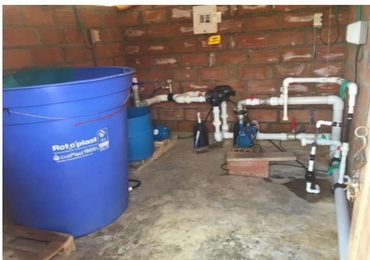
Ilustración 11. Sistema de bombeo.
