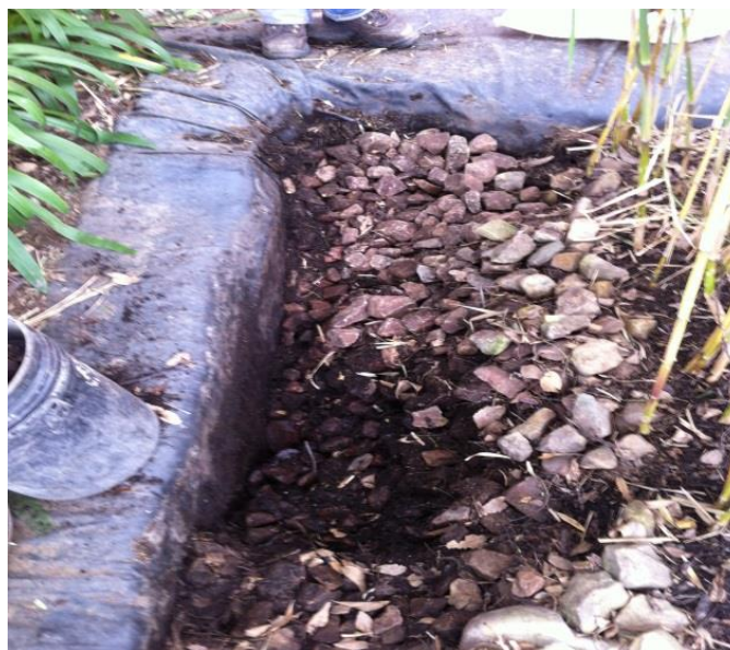
Figura 9: limpieza filtro de grava entrada
