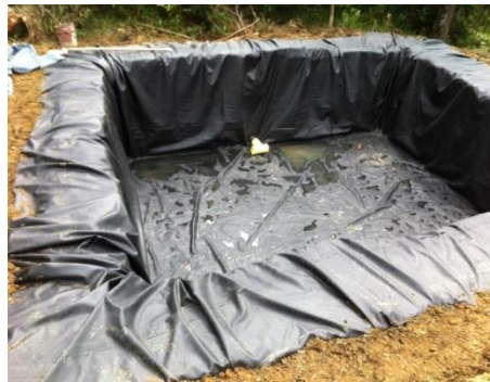
Figura 24: geomembrana instalada
