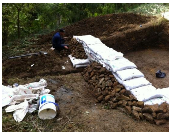
Figura 23: muro y talud salida PTARD LF
