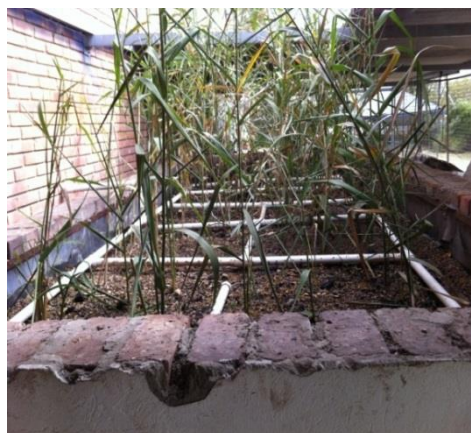
Figura 8: instalación tubería de distribución
