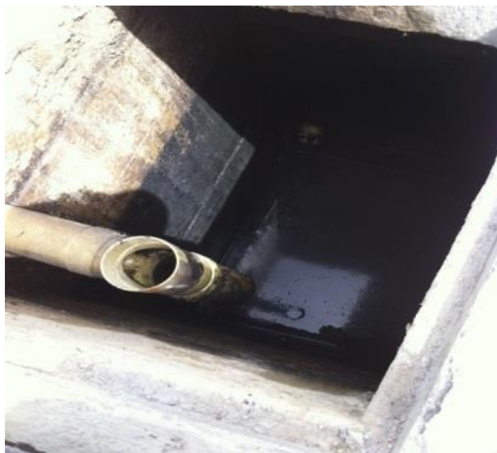
Figura 15: sedimentador recién evacuado
