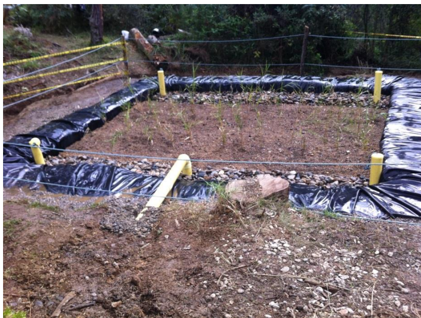
Figura 30: PTARD LF terminada
