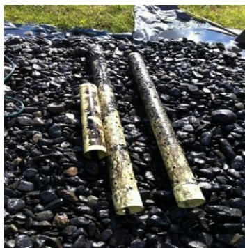
Figura 12: tubería de distribución retirada
