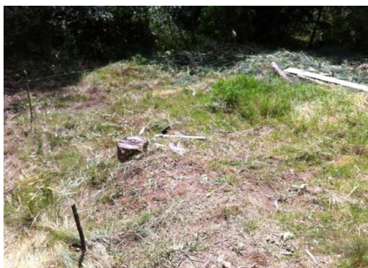
Figura 19: localización y replanteo
