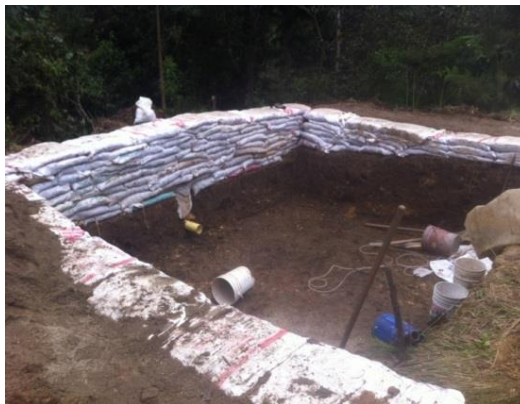
Figura 22: muros y taludes
