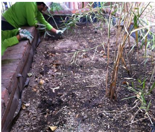
Figura 5: retiro tubería de distribución
