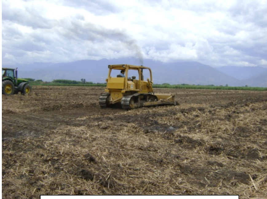
Foto N° 1: Nivelación del terreno
