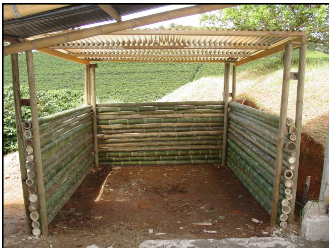
Figura 22. Procesadora de pulpa construida en guadua. Finca “La Ilusión” corregimiento “Alegrías” municipio de Caramanta, Antioquia
