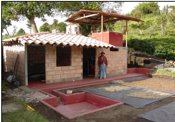
Figura 5. Beneficiadero de café con encierro en mampostería en la finca “Cañada seca” Vereda “La Hermosa” municipio de Jericó, Antioquia.
