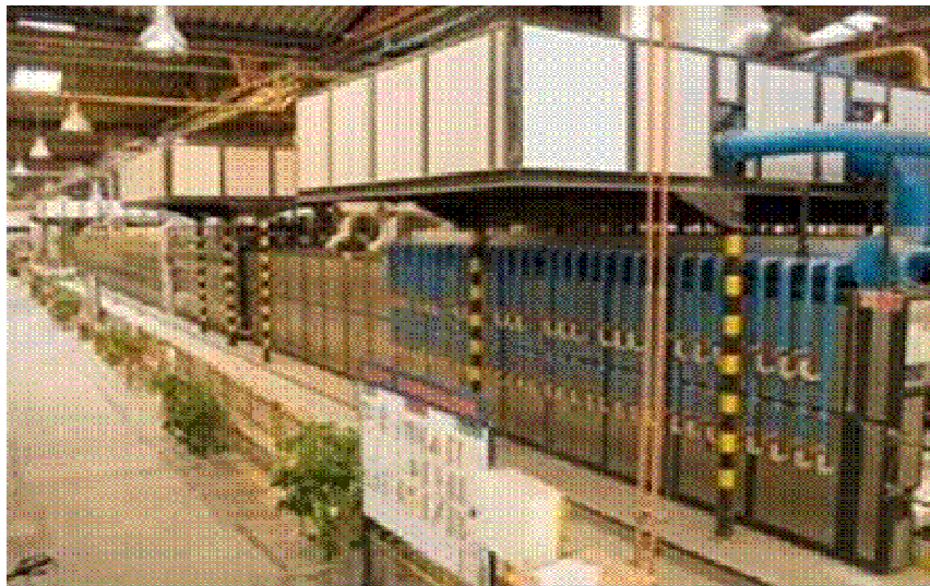
Ilustración 2 Instalaciones Aisladores Corona 2
