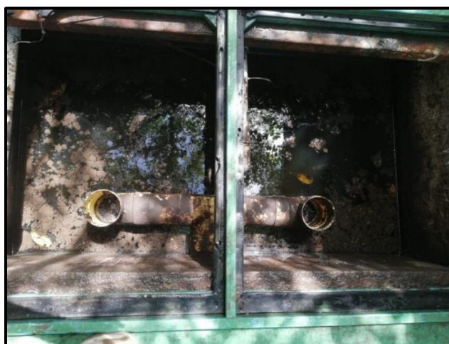
Foto 7. Sedimentador Secundario.
