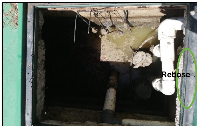
Foto 4. Tanque de Emergencia.
