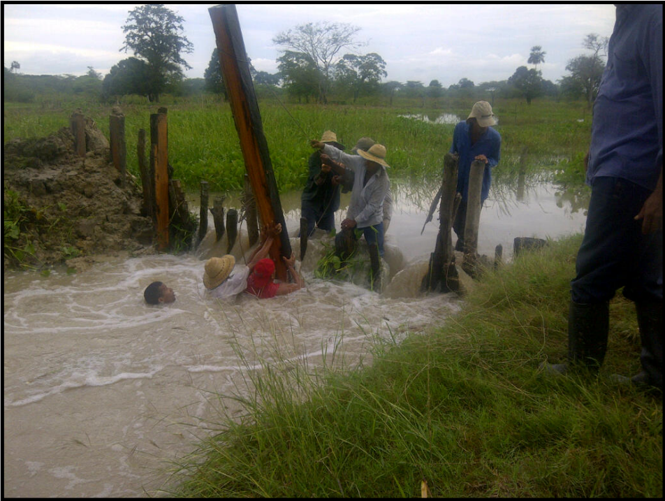
Imagen 28. Obras de contención de las aguas
