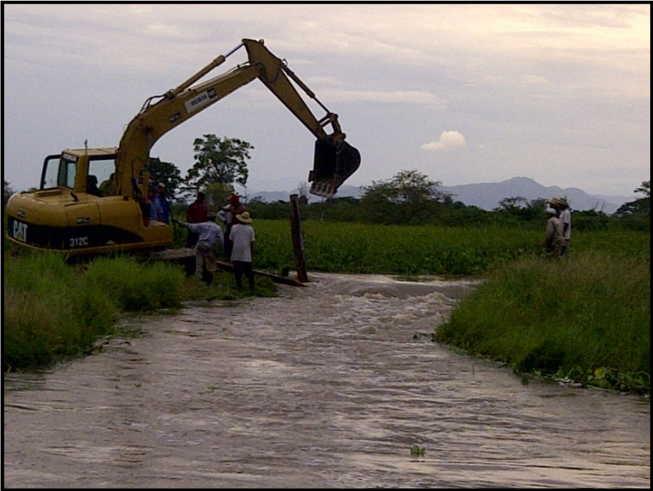
Imagen 29. Maquinaria en labores de drenaje de potreros
