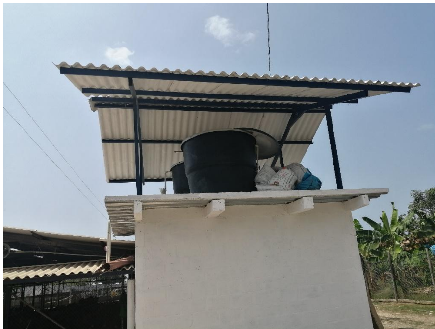
Ilustración 2 implementación de techos para cubrir los tanques elevados.
