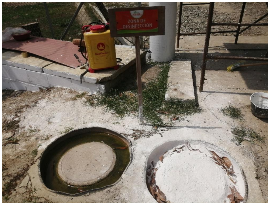
Ilustración 1 implementación de pediluvios y bomba para desinfección.
