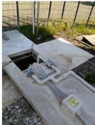
Ilustración 33: Tanque de recibo: 5m3
