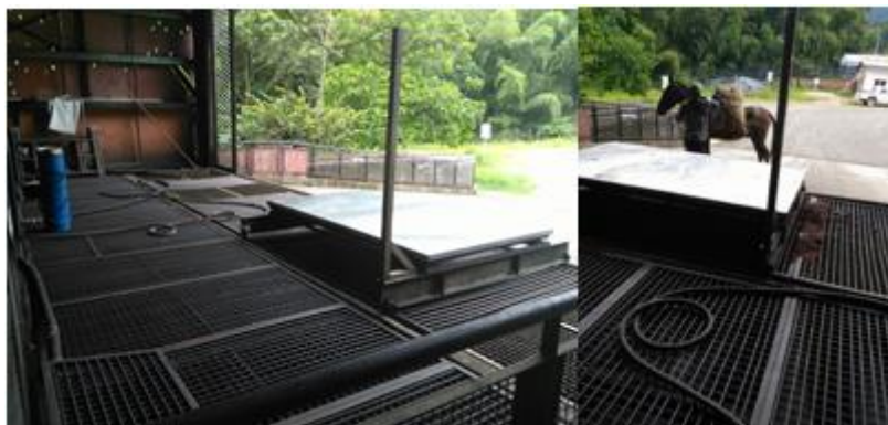
Ilustración 21: Área de recepción – tolvas / ingreso de materia prima:
