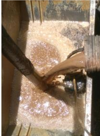
Ilustración 32: Sistema de bombeo de aguas servidas (sube al tamiz y de tanques pulmones pasa directo a la planta)
