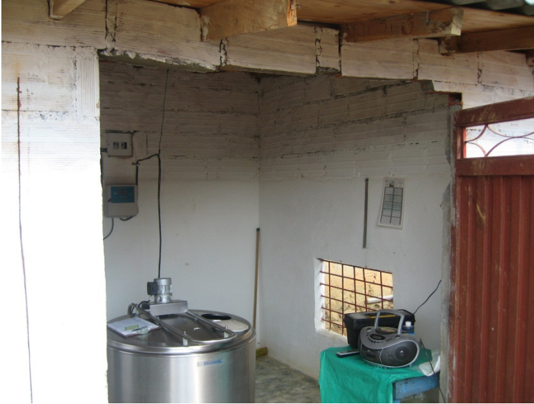
Foto 2 Cuarto De Tanque
