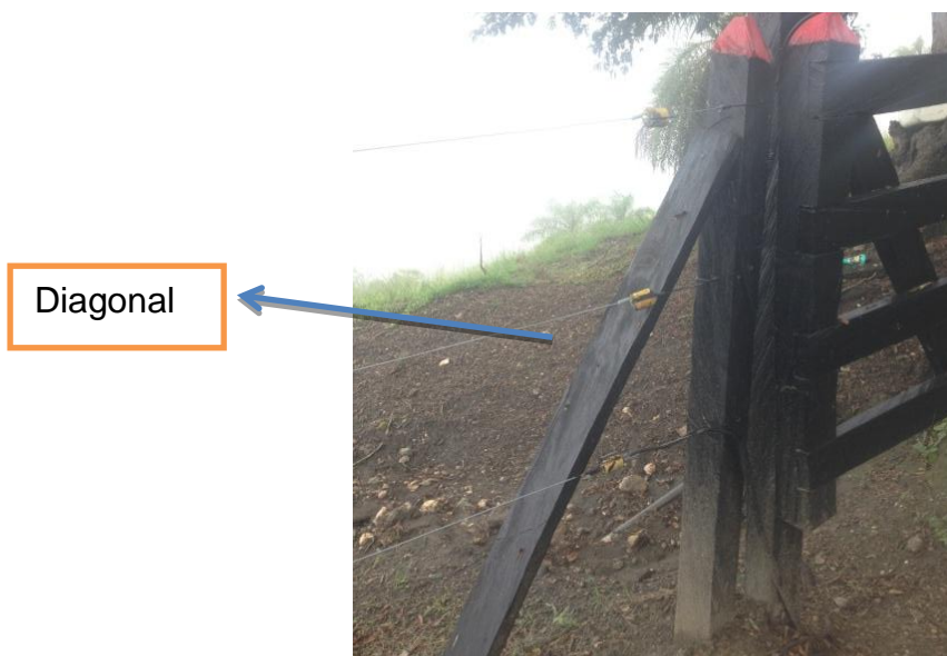
Foto 8. Poste diagonal para apuntalar cerca
