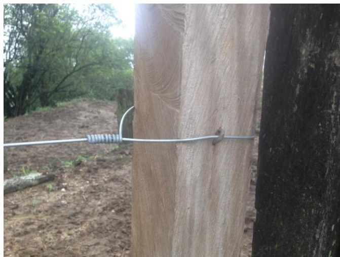
Foto 14. Inicio de la colocación del alambre de púas
