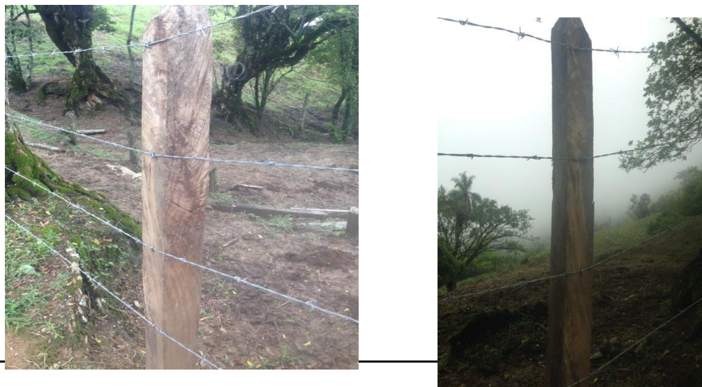
Foto 17. Instalación de las diferentes cuerdas de alambre de púas
