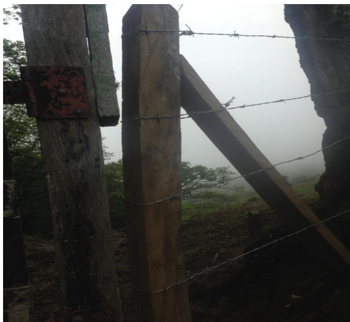
Foto 18. Estacón diagonal para tensar el alambre de púas
