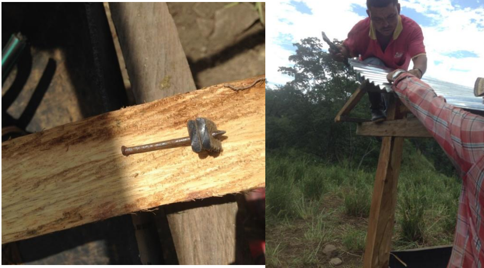
Foto 25. Techado del saladero
