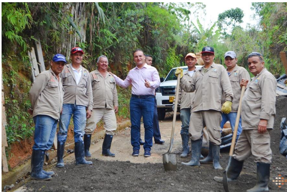
Fotografía de Nelson Mario Murillo La Estrella-2017 Alcalde Johnny García y trabajadores oficiales construcción vía La Cuchilla – Fuente: Oficina de Comunicaciones Alcaldía de La Estrella
