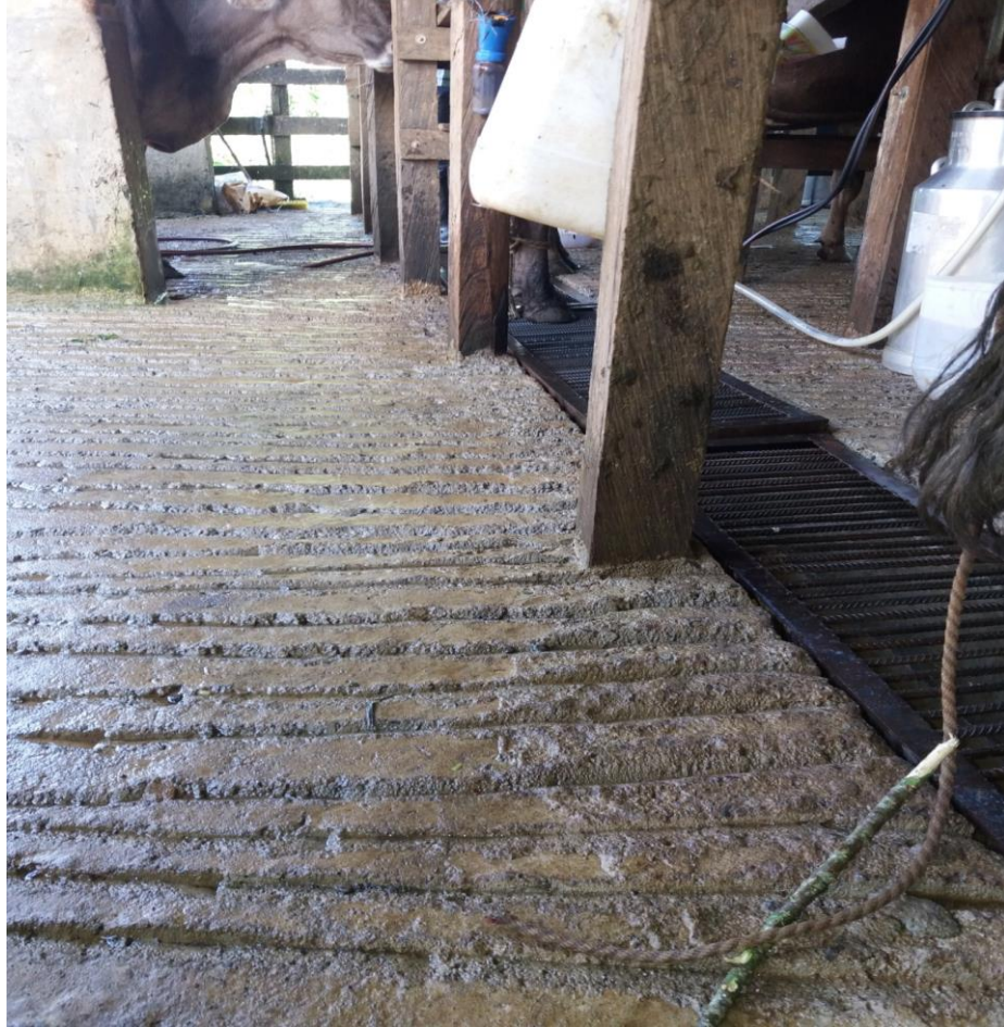
Foto 7. Canal y pisos nuevos.
