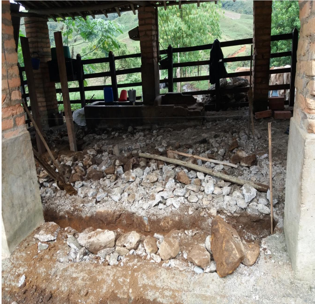
Foto 6. Remodelación sala de ordeño
