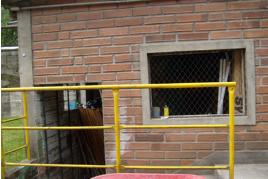
Foto 19. Cuarto de almacenamiento de residuos peligrosos
