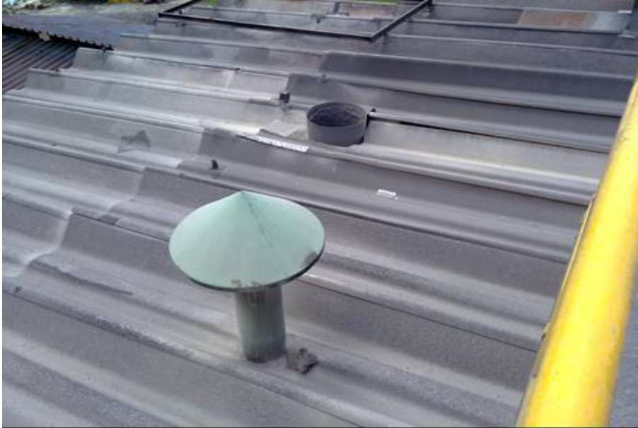
Foto 23. Chimenea del molino y la caldera
