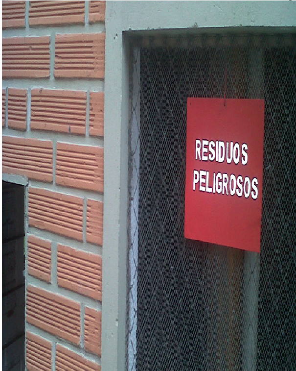
Foto 32. Almacenamiento de residuos peligrosos
