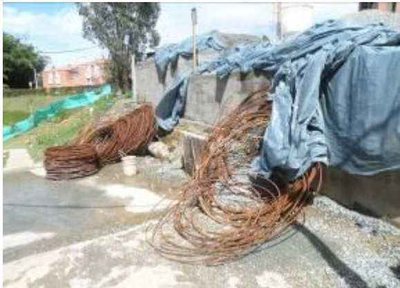
Foto 51. Almacenamiento materiales construcción
