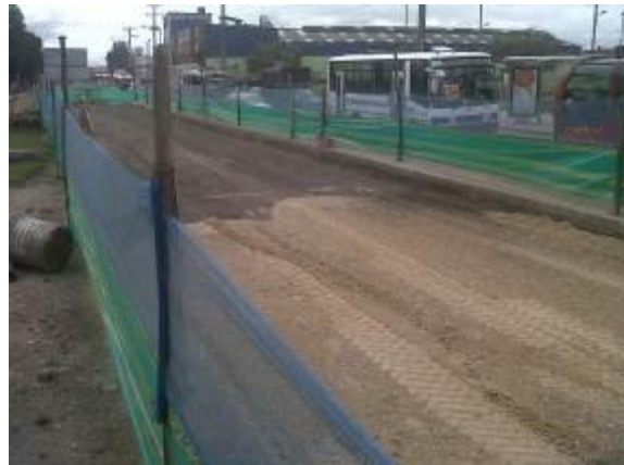
Foto 4. Aprovechamiento de bases y subbases
