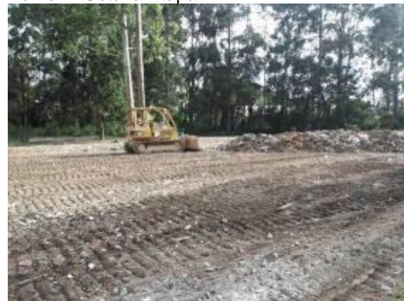
Foto 22. Recuperación punto crítico Sector El Porvenir Octava Etapa
