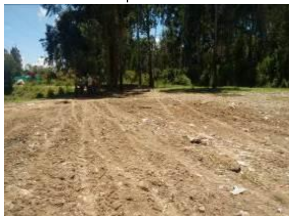
Foto 24. Recuperación punto crítico Sector El Porvenir Octava Etapa
