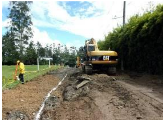
Foto 83. Movimiento de tierras Vía Caucanas - Kakaraka
