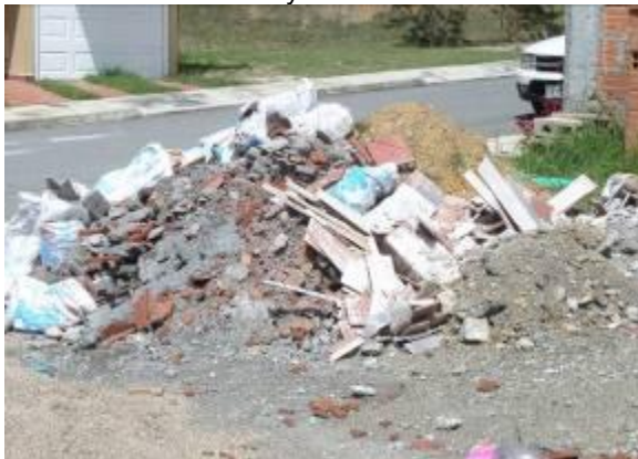
Foto 48. Disposición inadecuada de RCD Urbanización El Caney
