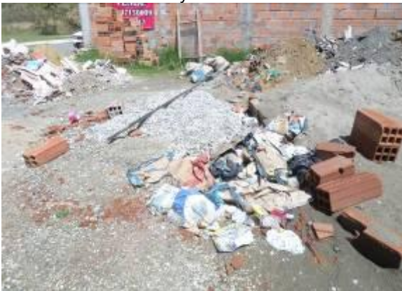
Foto 47. Disposición inadecuada de RCD Urbanización El Caney
