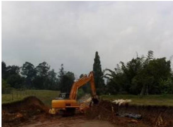
Foto 82. Movimiento de tierras Vía Caucanas Kakaraka
