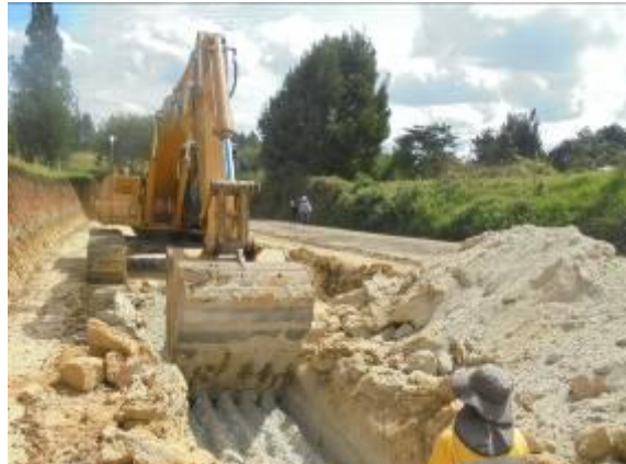
Foto 81. Movimiento de tierras Vía Caucanas - Kakaraka
