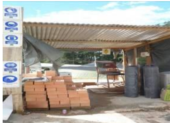
Foto 50. Almacenamiento materiales construcción
