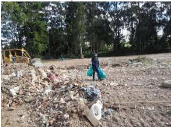
....Foto 21. Recuperación punto crítico Sector El Porvenir Octava Etapa
