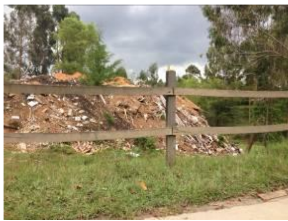
Foto 93. Punto crítico Parqueadero Municipal
