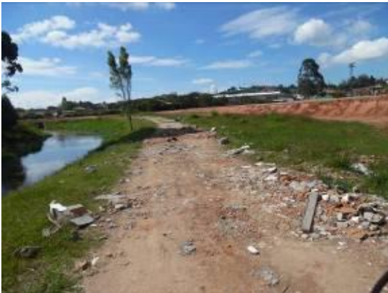
Foto 11. Disposición inadecuada de RCD Sector El Porvenir
