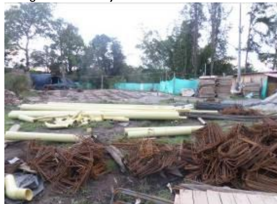
Foto 77. Almacenamiento materiales construcción Colegio Liborio Mejía
