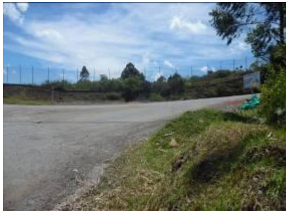
Foto 30. Disposición inadecuada de escombros Sector Los Sauces
