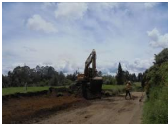
Foto 80. Vista general Vía Caucanas Kakaraka
