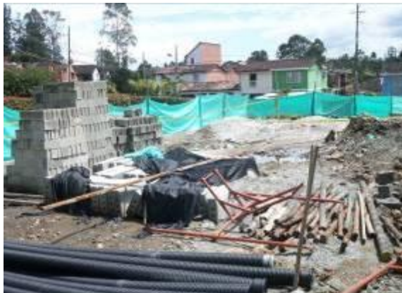
Foto 69. Almacenamiento materiales construcción Gimnasio Los Remansos
