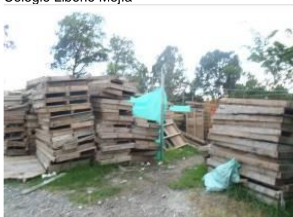
Foto 75. Almacenamiento materiales construcción Colegio Liborio Mejía
