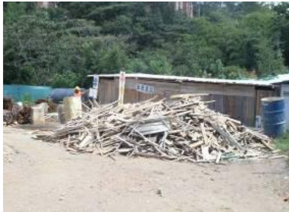
Foto 52. Clasificación de RCD
