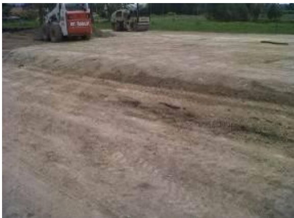
Foto 3. Aprovechamiento de bases y subbases
