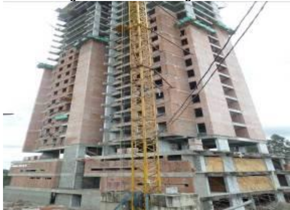
Foto 53. Vista general Edificio Riogrande
