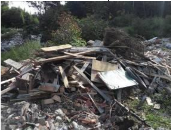
Foto 17. Disposición inadecuada de RCD Sector El Porvenir Octava Etapa
