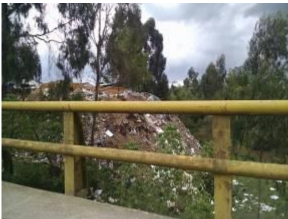
Foto 92. Punto crítico Parqueadero Municipal
