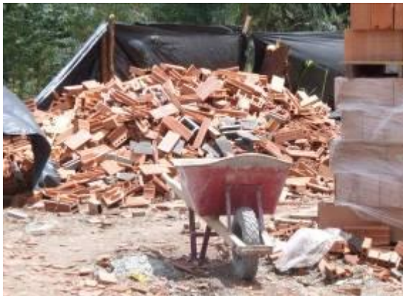
Foto 54. Clasificación de RCD
