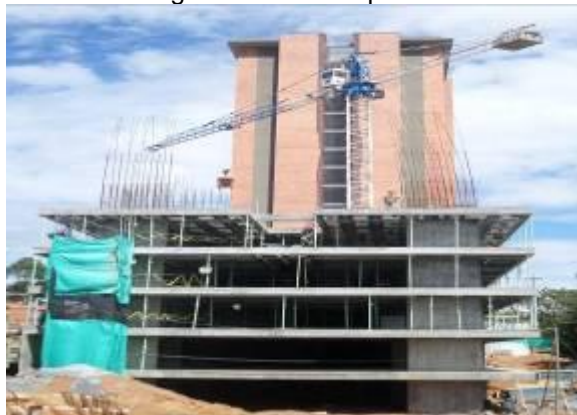
Foto 49. Vista general Edificio Ipanema
