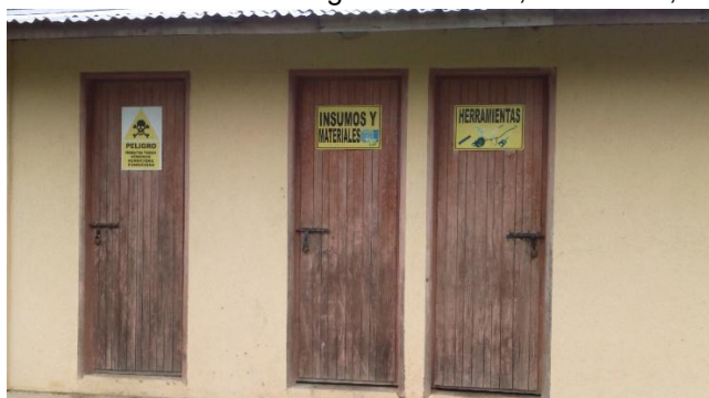
Instalaciones de la hacienda. Bodega de insumos, herbicidas, herramientas
