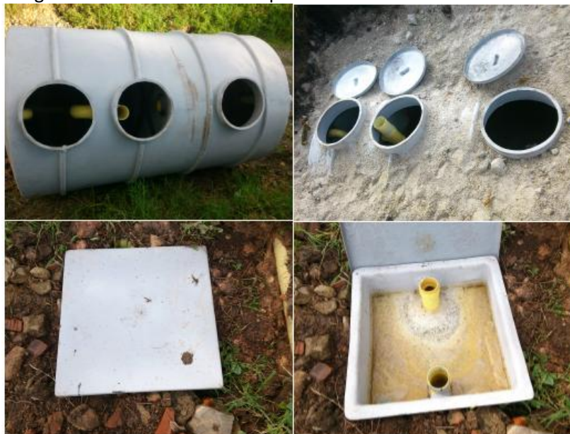
Imagen 8 Instalación sistema séptico
