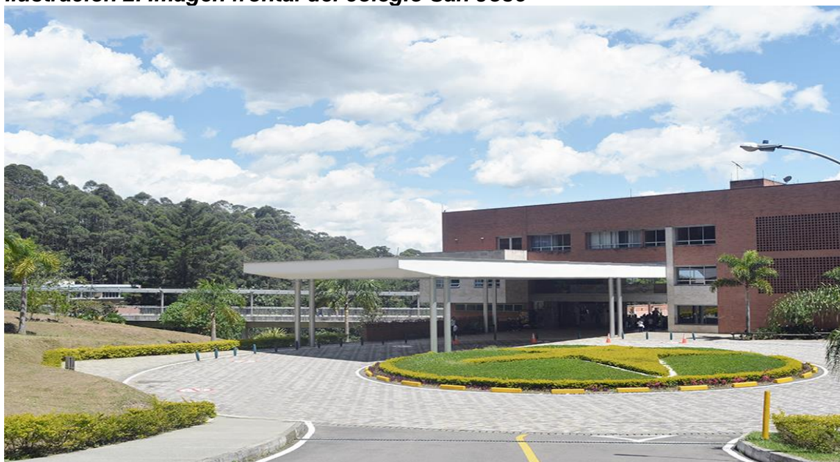
Ilustración 2. Imagen frontal del colegio San José
