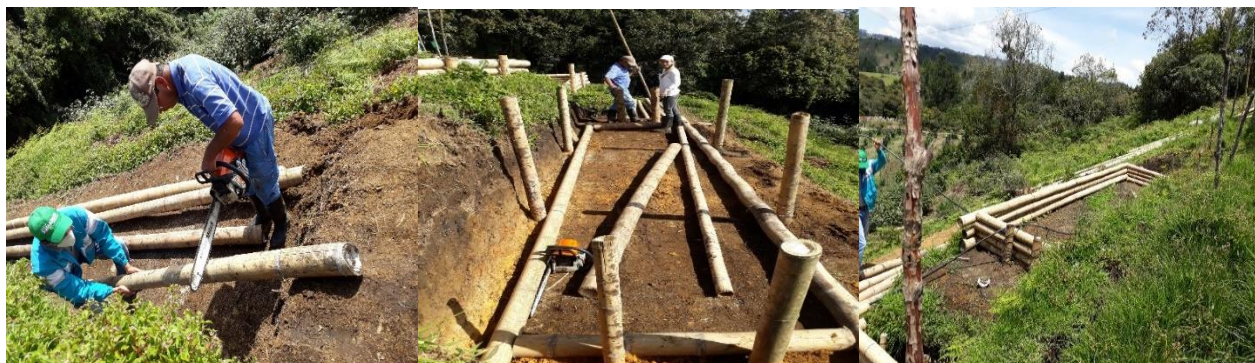
Figura 6. construcción del sistema acuapónico artesanal.
