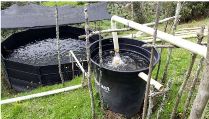
Figura 13. Tanque de filtración que pasa del tanque dos al tanque número tres.
