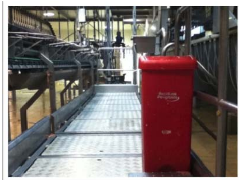
Imagen 4. : Recipiente de residuos peligrosos en eviscerado
