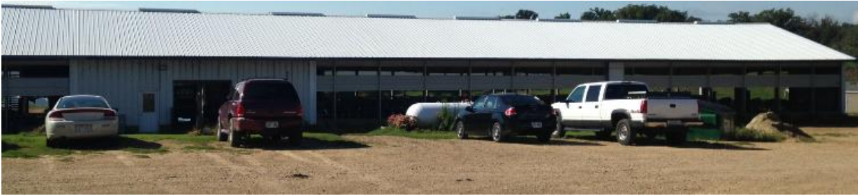
Ilustración 10: Calf Barn vista exterior
