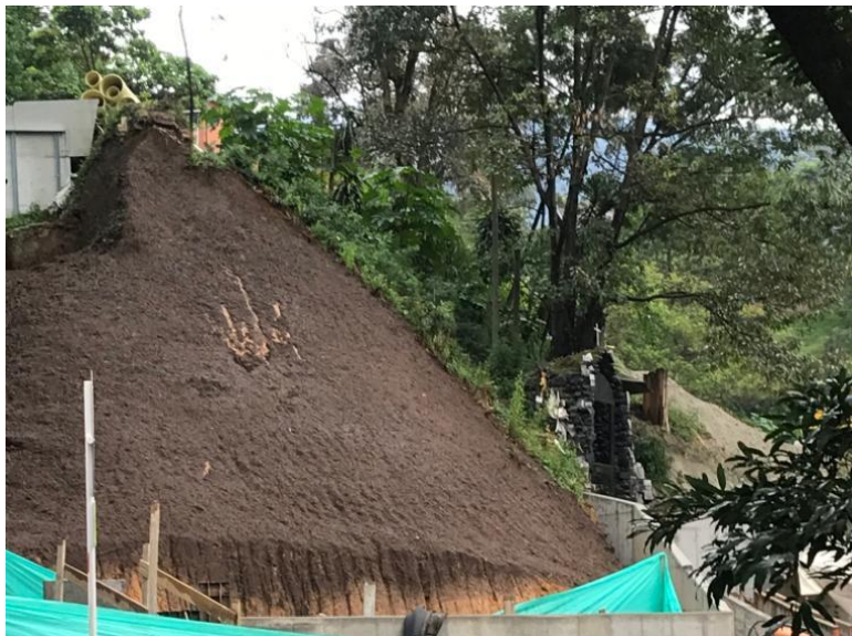
Ilustración 5. Establecimiento de taludes y aplicación Contenido Ruminal
